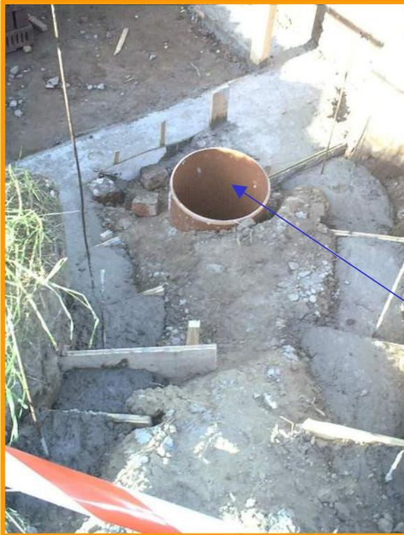
Mehrstufige flache Treppen haben wir mit einer provisorischen Schalung versehen auch im Groben gießen lassen. Das Sammlerrohr ist eingelassen
