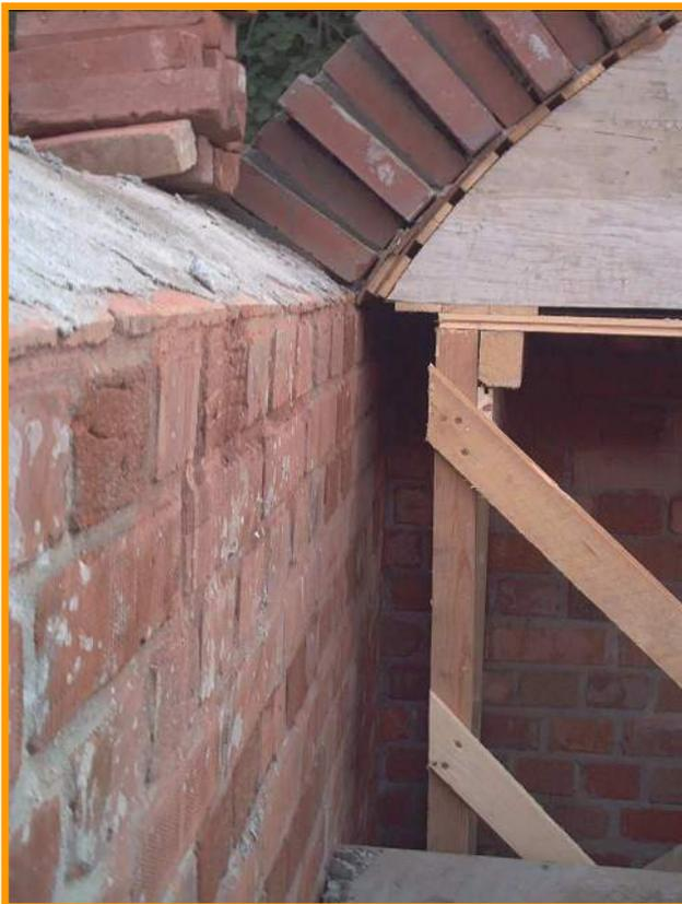
Hier noch einmal eine Nahaufnahme. Es wird natürlich von der linken Mauerseite zur Mitte und rechten hin gemauert
