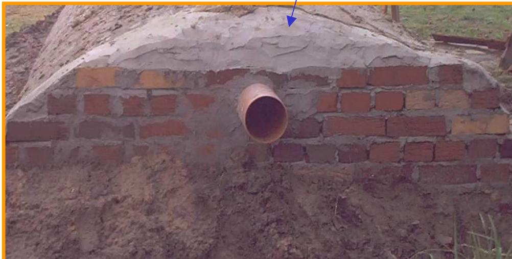
Die Abdichtung des Rundbogens erfolgte nicht mit einer Folie sondern mit einer 10cm dicken Lehmschicht. Aufnahme von der Rückseite aus gesehen. Zu erkennen ist das Lüftungsrohr
