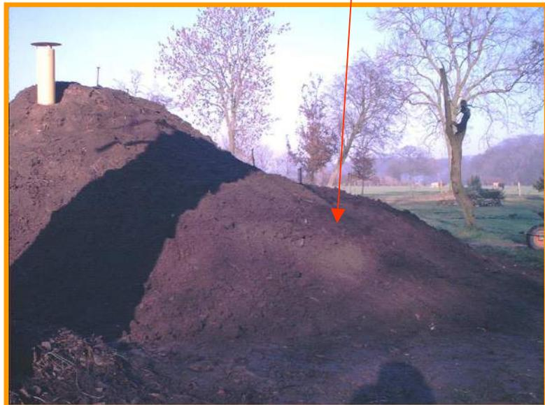
Der Erdaushub wurde auf den Lehm aufgetragen und darüber eine Schicht Kompost. Beides zusammen ca. 70-100cm Schichtdicke
