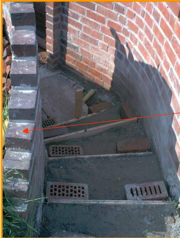
Nach ein paar Flex- und Meißelarbeiten wurde die Schalung für die Treppe gefertigt und gegossen.
