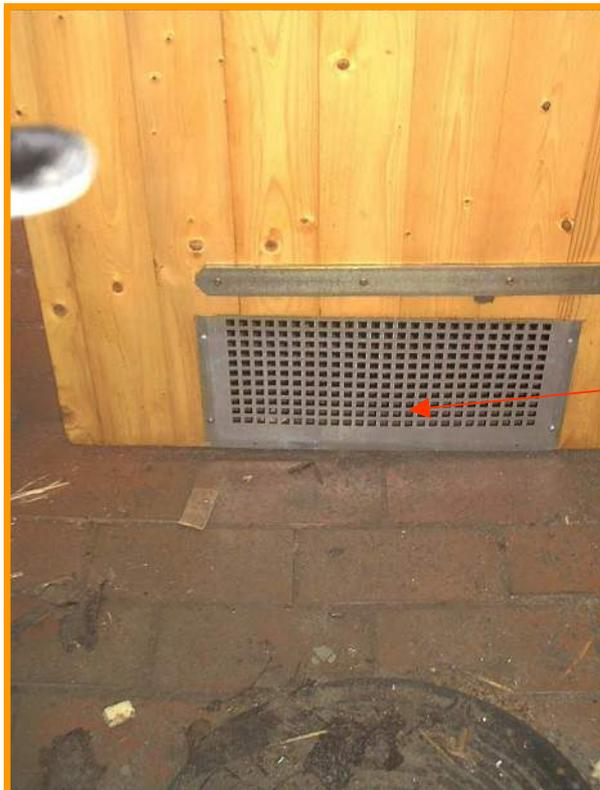
Um ein zu feuchtes Innenleben im Keller zu vermeiden sind Lüftungsgitter an der Tür angebracht
