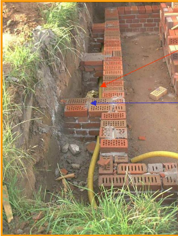
Ein Dränagering wurde um den ganzen Bau herum gelegt, mit Kies unterlegt und bedeckt und in den Dränagesammler geführt
